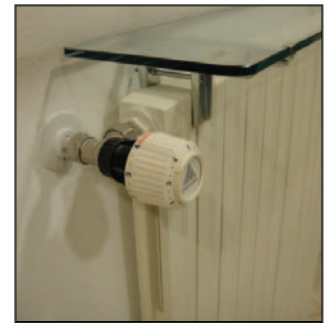
Fig. n. 4: Valvola termostatica
